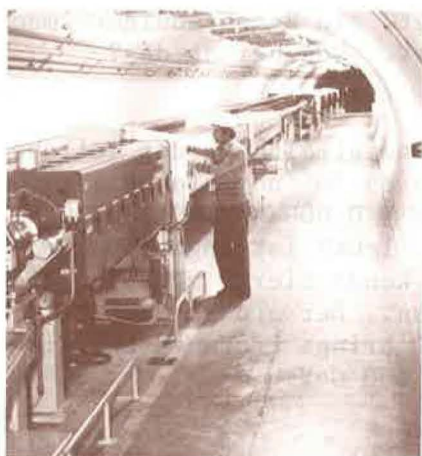
Blick in den Tunnel des grossen CERN-Synchrotrons (SPS). Ringdurchmesser 2,2 km; Protonenenergie über 400 GeV.
